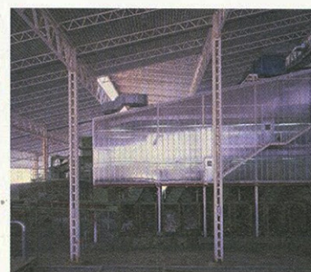
335 - INTERIOR DE LA PLANTA DE RECICLAJE
